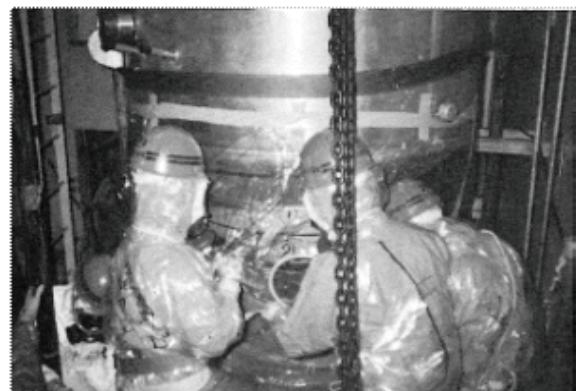
図5-4 酸回収蒸発缶の解体撤去作業
